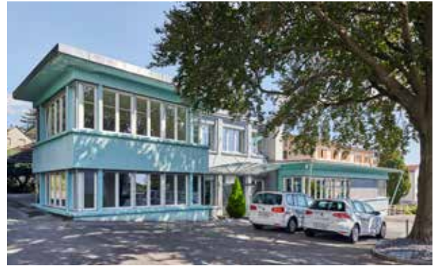
Mechanische Werkstatt Grenchen / Lager
