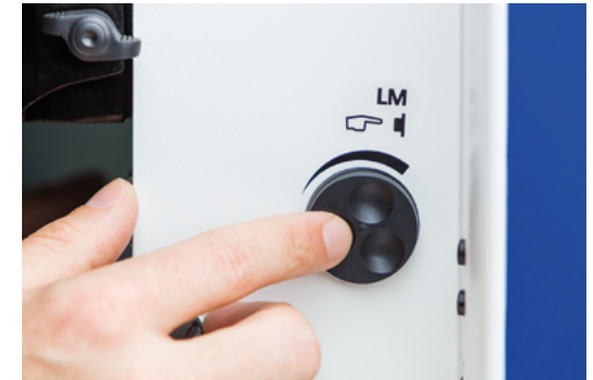
Commande de la gestion d'éclairage
